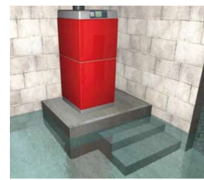
Mise hors d'eau de la chaudière.
