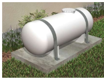
Ancrage de la cuve.
